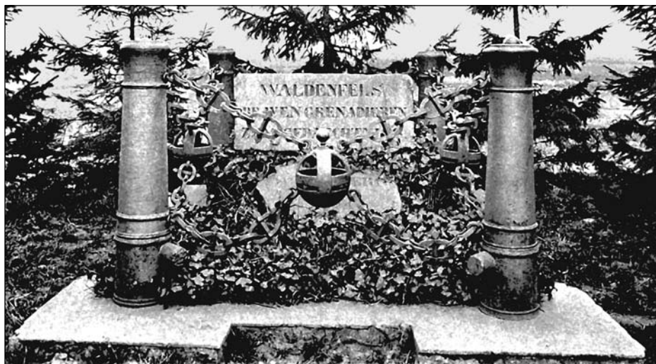
Zbiorowy grób wtórny przy amfiteatrze z upamiętnieniem grenadierów Waldenfelsa. Zniszczony w 1945 r.
